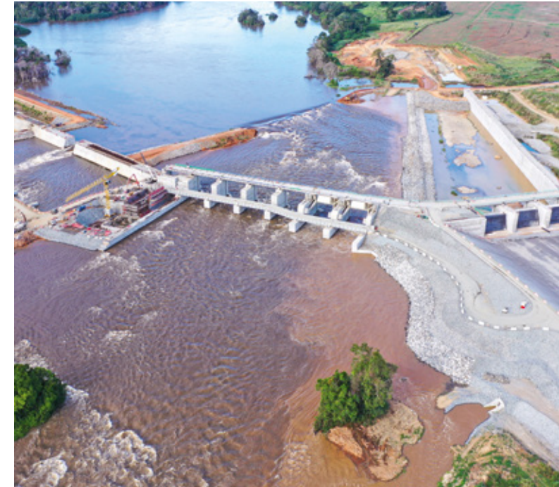
Les travaux pour le barrage de Nachtigal au Cameroun étaient avancés à 80 % fin 2022
