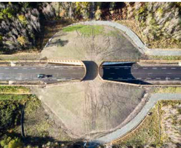
▼ Paso de fauna para la circunvalación Taillan-Medoc
